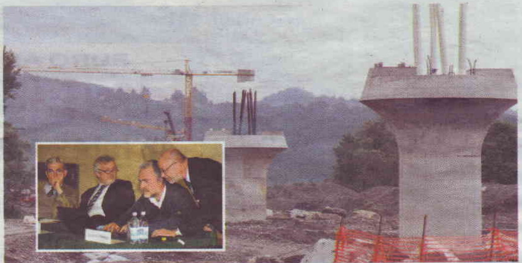
Lavori in corso per il nuovo ponte sul Po, nel riquadro: Daniele Borioli
