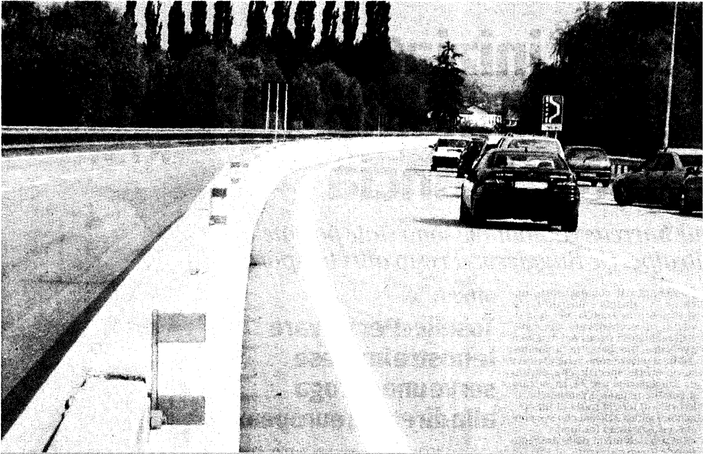
TANGENZIALE EST Il centrodestra attacca le scelte della giunta Saitta e chiede che l'infrastruttura venga realizzata in tempi brevi
