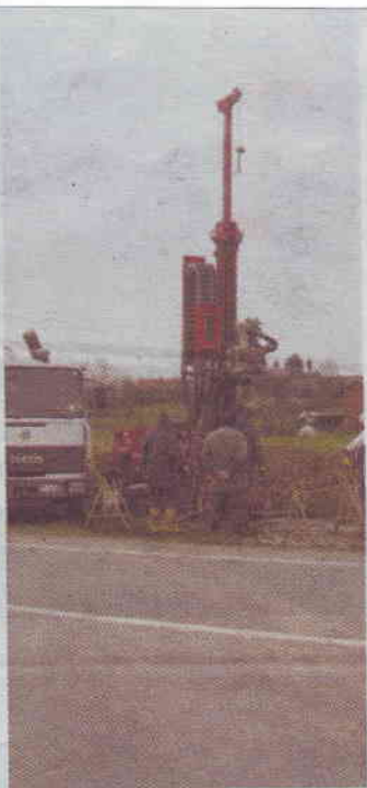
Tangenziale Est. Primi lavori
