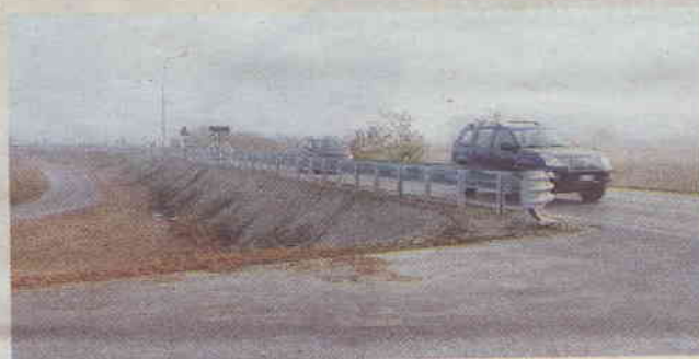
La statale 590, nei pressi del nuovo ponte sul Po
