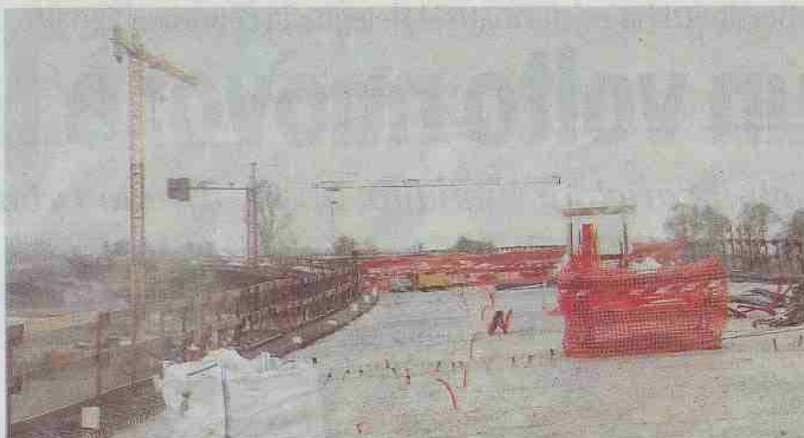
Al cantiere, lungo la strada 590, proseguono incessanti i lavori per completare il ponte sul Po. Devono ancora essere collegate alla struttura tre campate
